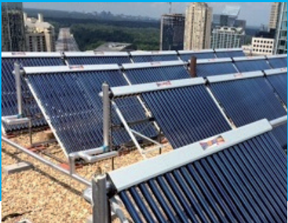
Collectoren voor het opvangen van zonnewarmte, mogelijk op een nieuw parkeerdak op het Jan Ligthartplein.
